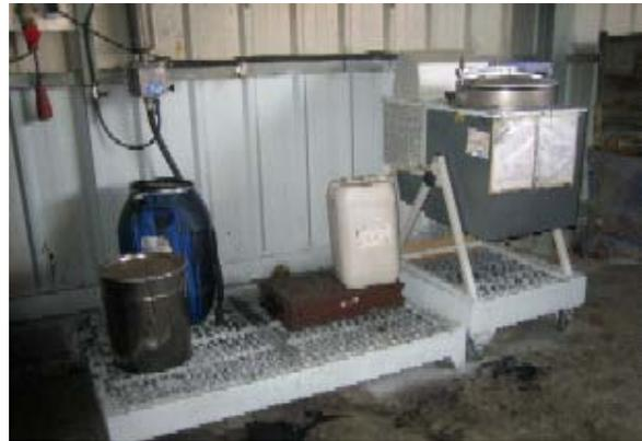
*Alguns exemplos de equipamentos e práticas para recuperação de resíduos de solventes com dispositivos para prevenção e contenção de derrames.*
