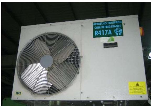
Equipamento de refrigeração com identificação do fluído de refrigeração.
